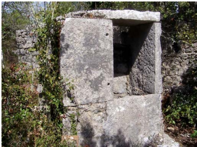
Un puits-citerne bien conservé
