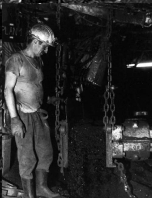
Les ouvriers au rocher : Ils creusent les travers-bancs, les galeries à travers les bancs de rocher pour atteindre les veines de charbon.
